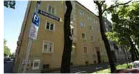
Schwabing, Ecke Ansprenger-, Destouchesstraße
