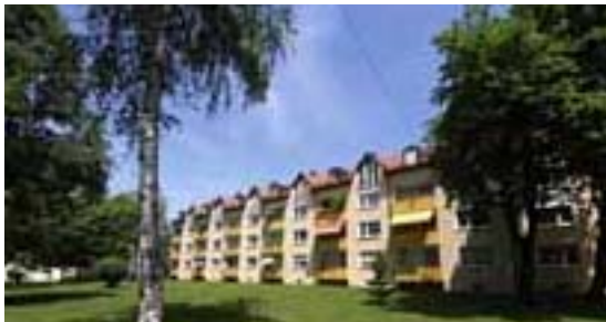
München, Cimbernstraße, Dachgeschossausbau
