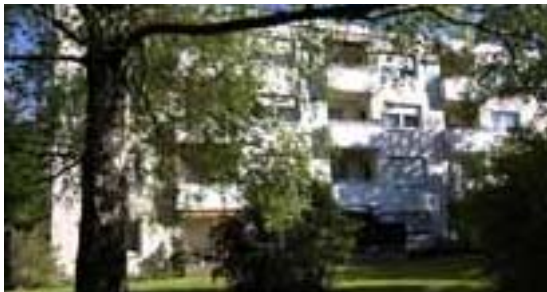
Germering, Schillerstraße, Gartenseite
