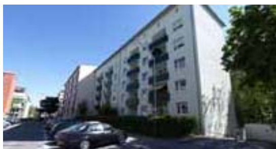
München, Karwendelstraße, Tiefgarage
